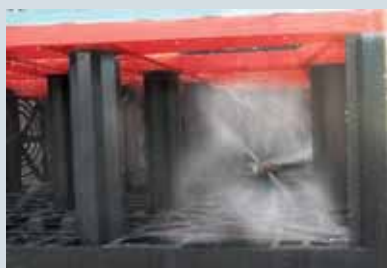
Čištění vsakovací galerie
