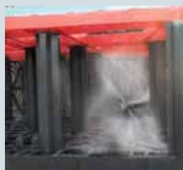
Jednoduchá inspekce a čištění
